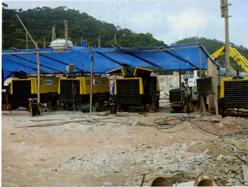
Figura 29 – Compressores do tubulão. Fonte: Autor, 2008
