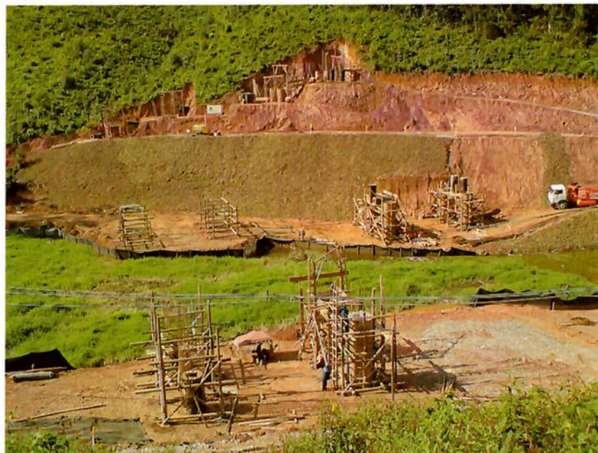
Figura 25 – Formas para concretagem da camisa Fonte: Autor, 2008
