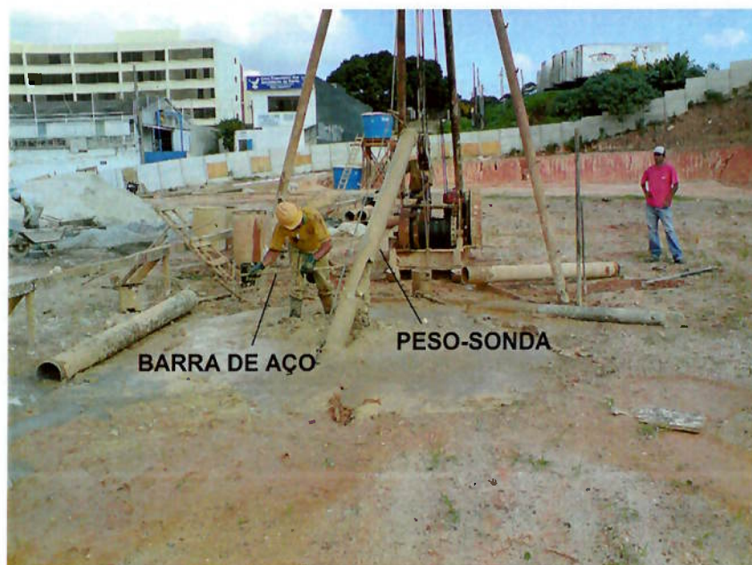
Figura 12 – Utilização de barra para retirada de lama do peso-sonda Fonte: Autor, 2008
