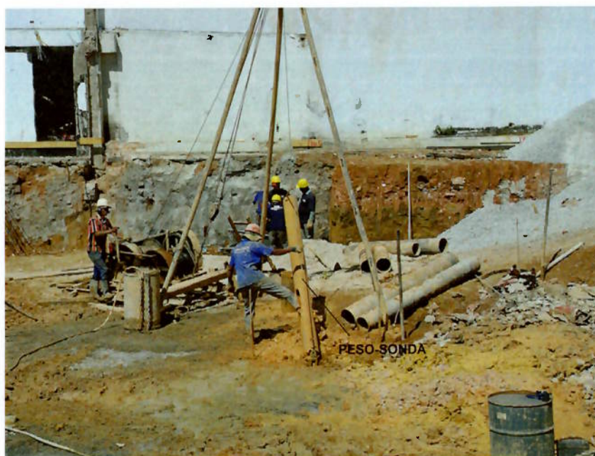
Figura 13 – Utilização do pé para retirada de lama do peso-sonda Fonte: Autor, 2009
