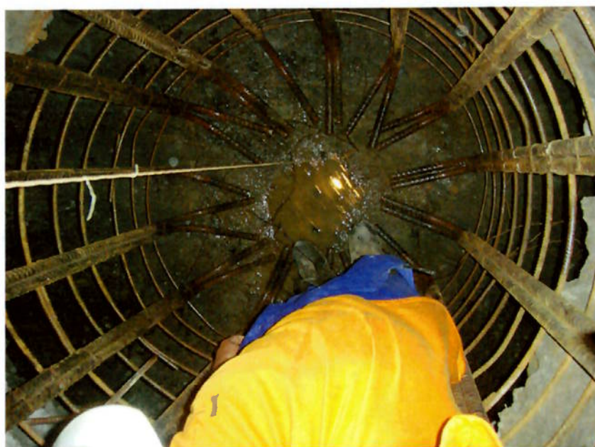
Figura 35 – Verificação da armação Fonte: AUTOR, 2009
