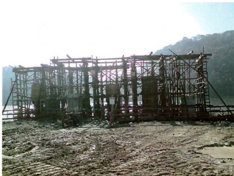
Figura 22 – Aterro e estrutura de madeiras para execução de tubulão Fonte: Autor, 2008
