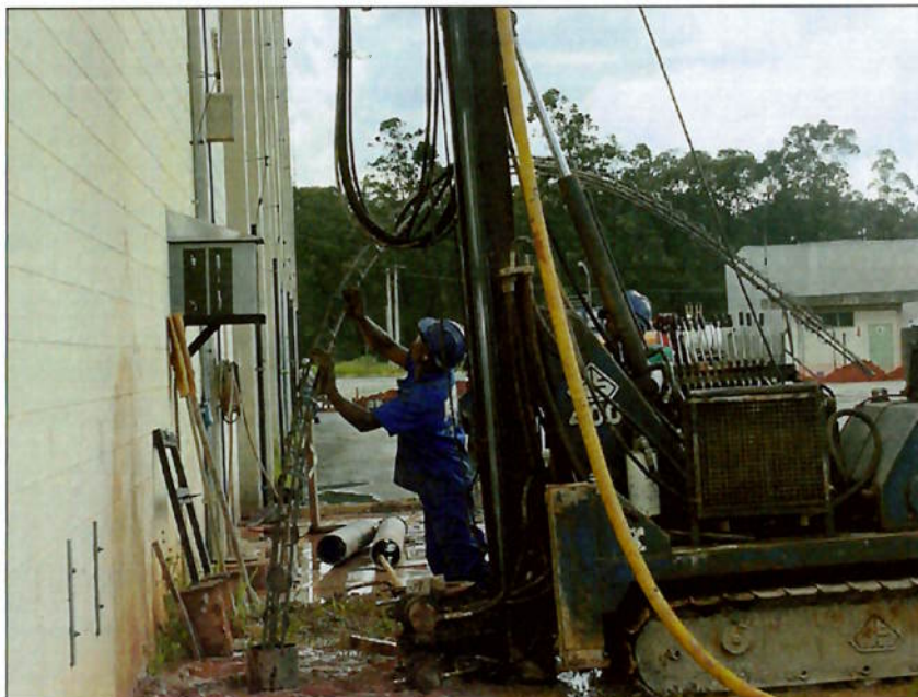
Figura 15 – Instalação da armação da estaca Raiz Fonte: Autor, 2005
