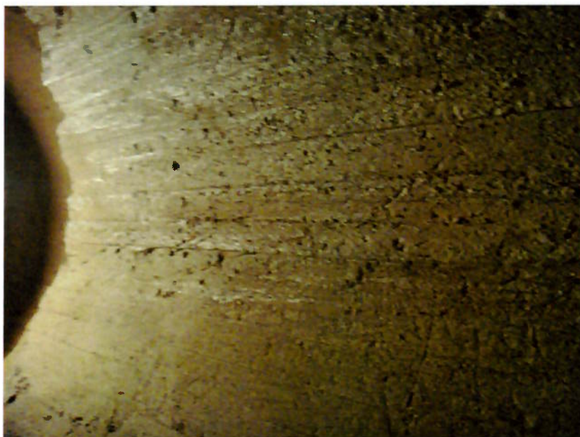
Figura 31 – Parede do fuste com bicheiras Fonte: Autor, 2009
