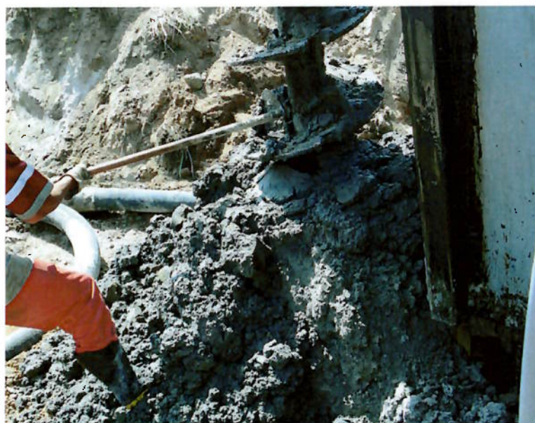
Figura 16 – Limpeza da estaca Hélice Contínua. Fonte: Autor, 2008
