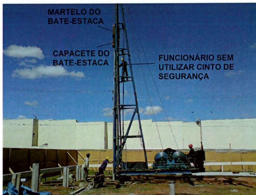
Figura 11 – Encaixe da estaca no capacete. Fonte: Autor, 2008
