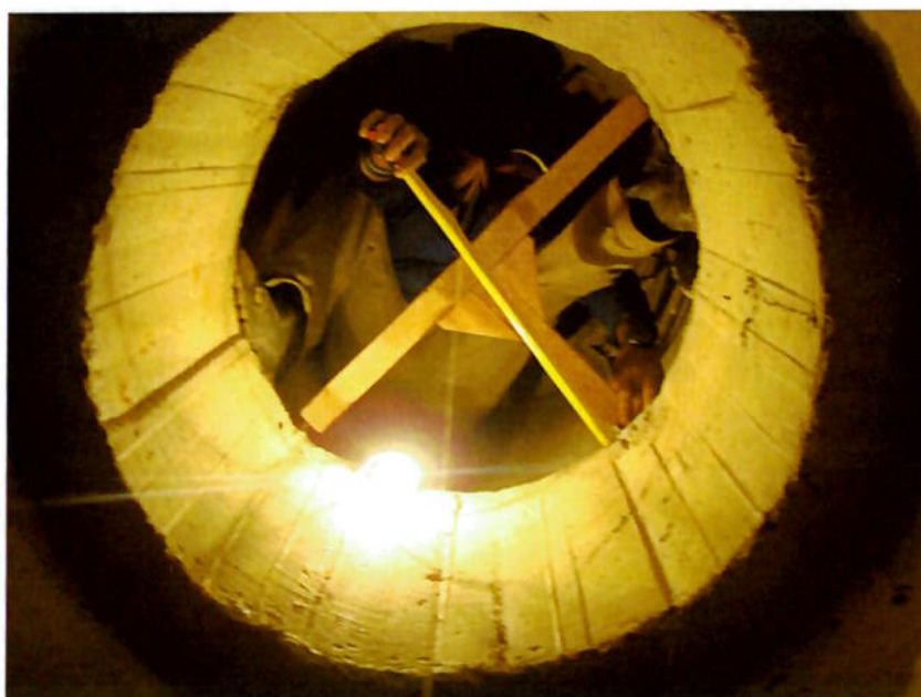
Figura 33 – Poceiro verificando prumo sem utilização de trava-quedas. Fonte: AUTOR, 2009
