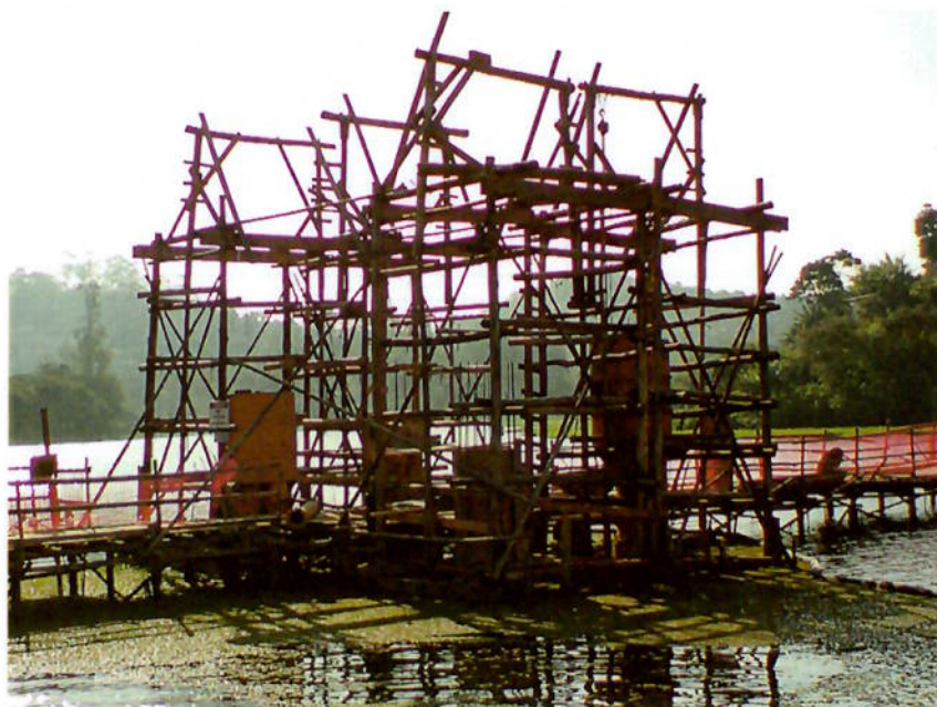
Figura 23 – Estrutura de madeiras para execução de tubulão na água Fonte: Autor, 2008
