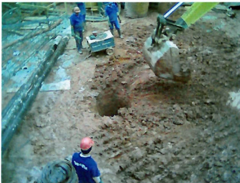
Figura 20 – Aterro da estaca escavada no quinto dia após a concretagem Fonte: Autor, 2006
