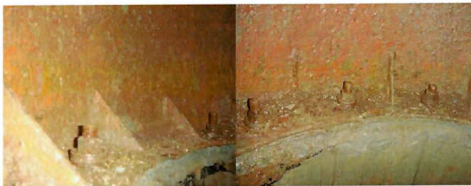
Figura 34 – Parafusos e chanfros aonde o poceiro se apóia. Fonte: AUTOR, 2009
