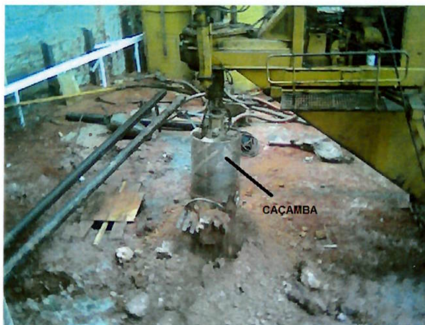
Figura 19 – Abertura da caçamba para liberação da terra escavada Fonte: Autor, 2006
