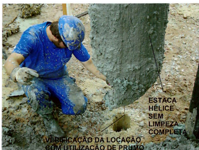
Figura 17 – Verificação da locação da estaca Hélice Contínua. Fonte: Autor, 2009
