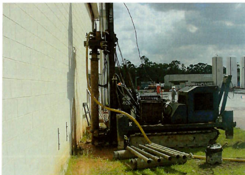
Figura 14 – Estaca Raiz Fonte: Autor, 2005
