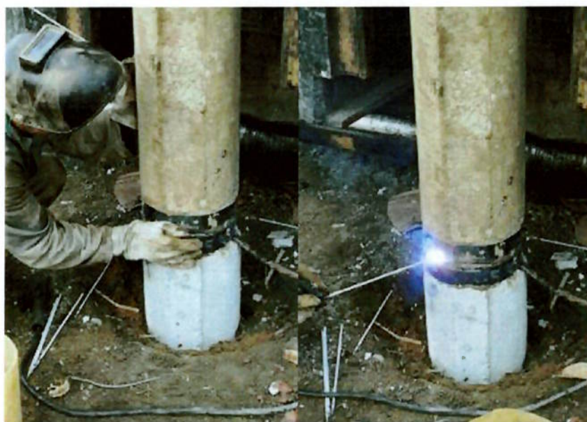
Figura 10 – Solda da estaca pré-moldada. Fonte: .Benaton, 25/10/09
