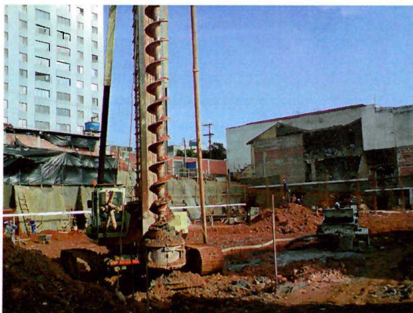
Figura 18 – Estaca Hélice Continua com restos de solo. Fonte: Autor, 2008
